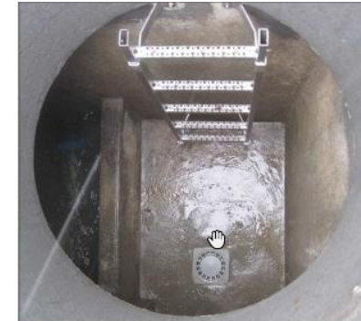
Chambre collectrice et trop-pleins
