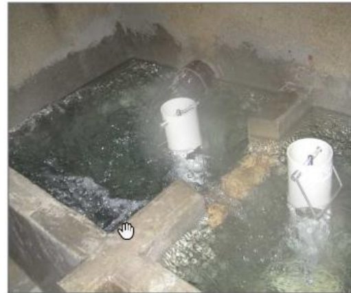
Chambre collectrice et trop-pleins
